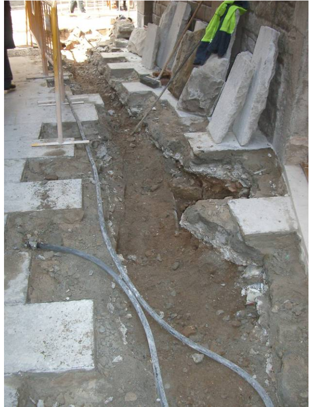
6. Vista general de la rasa al carrer Montjuïc del Bisbe
