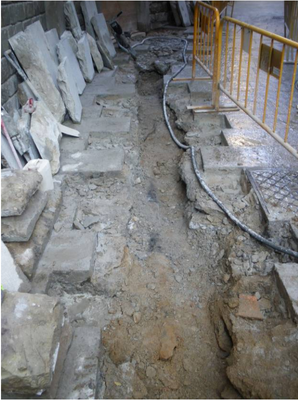
5. Vista general de la rasa al carrer Montjuïc del Bisbe
