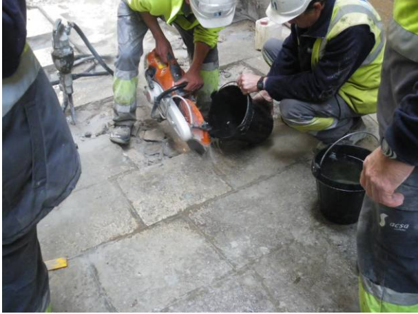
1. Operaris tallant les lloses del paviment
