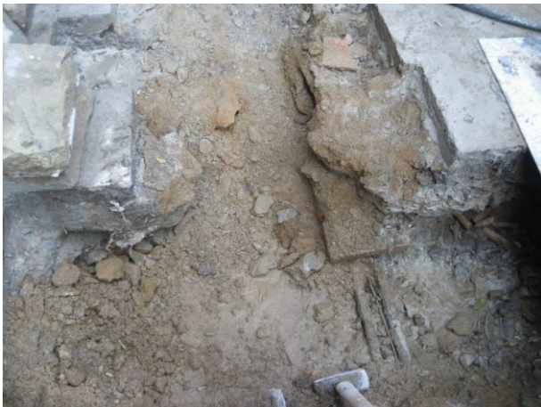
3. Detall de la rasa on es veu el cablejat de llum antic
